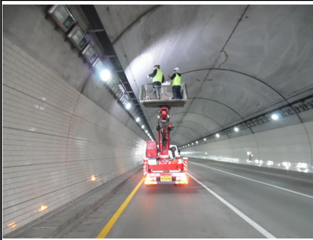
고소작업차를 이용한 현장조사(내부)
