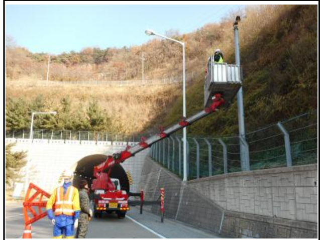
고소작업차를 이용한 현장조사(외부)
