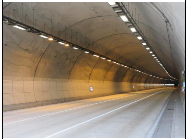
기장1터널(포항) 내부 전경
