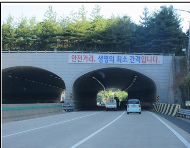
일광터널(부산) 갱구부 전경
