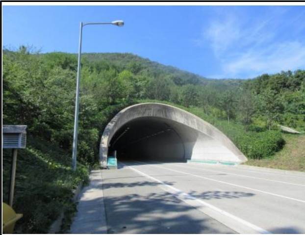
문수터널(부산) 갱구부 전경
