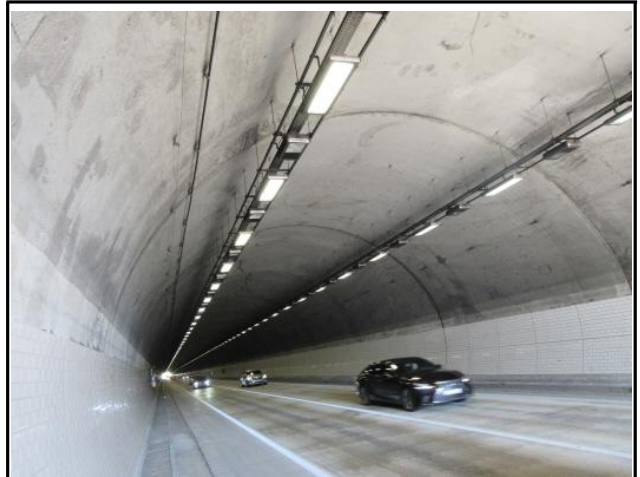
해운대터널(부산) 내부 전경
