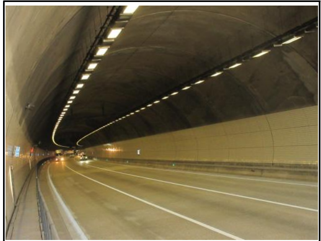
문수터널(부산) 내부 전경
