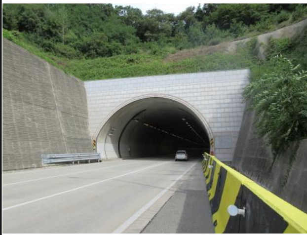
기장1터널(포항) 갱구부 전경
