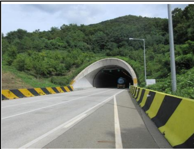
문수터널(포항) 갱구부 전경
