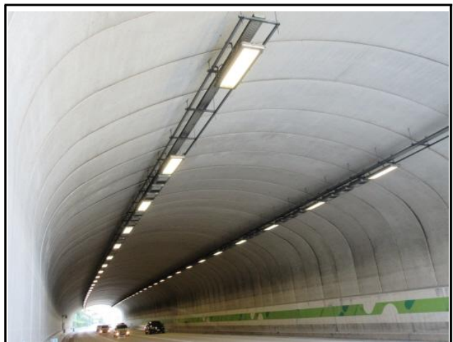
일광터널(부산) 내부 전경
