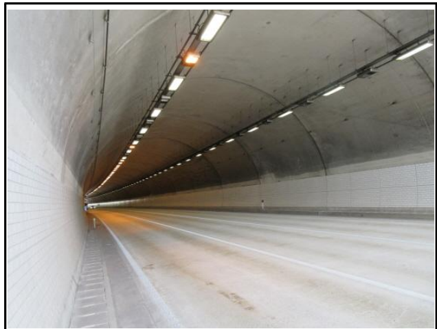
기장2터널(포항) 내부 전경
