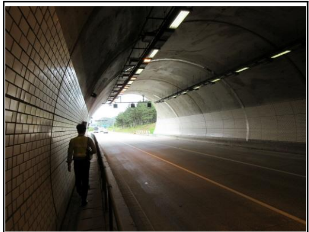
문수터널(포항) 내부 전경
