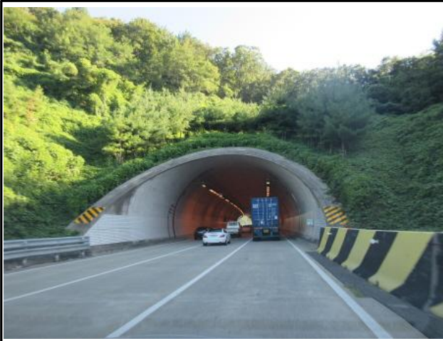
기장2터널(부산) 갱구부 전경
