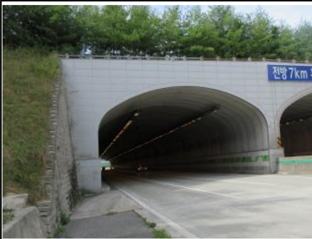
은양터널(포항) 갱구부 전경
