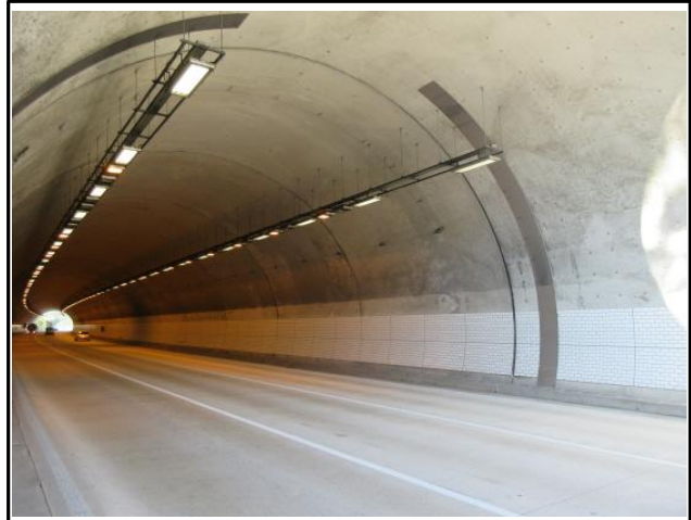
기장2터널(부산) 내부 전경
