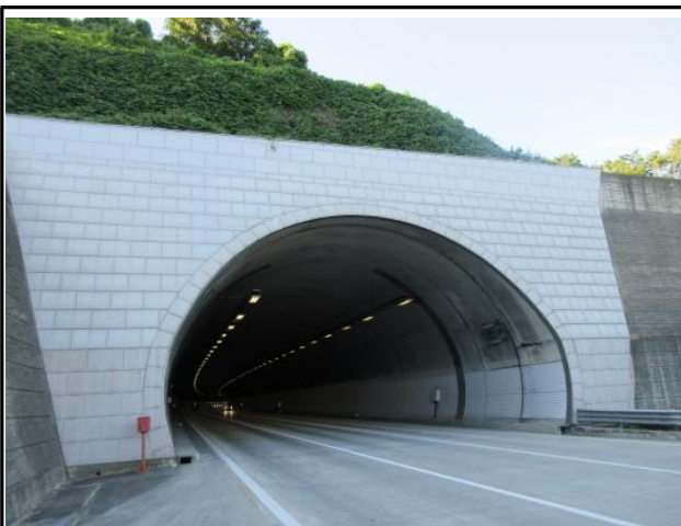
기장1터널(부산) 갱구부 전경
