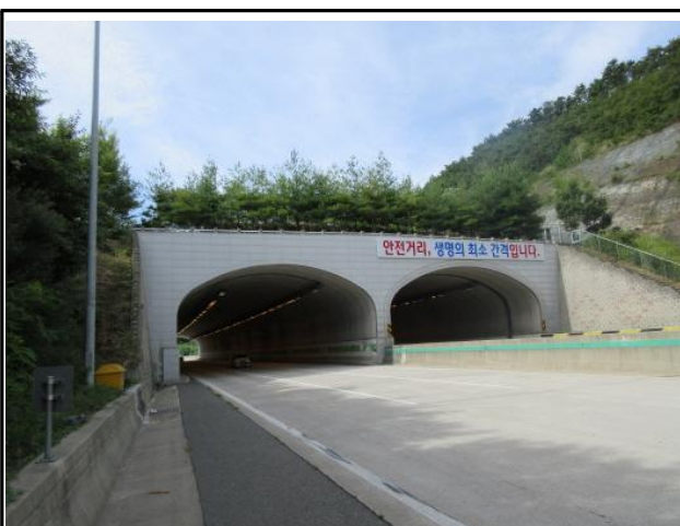
일광터널(포항) 갱구부 전경
