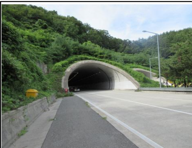
기장2터널(포항) 갱구부 전경
