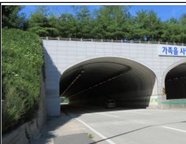
온양터널(부산) 갱구부 전경
