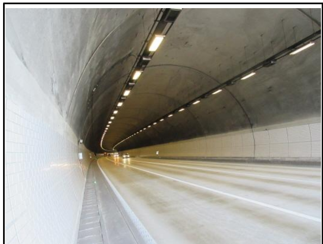
기장1터널(부산) 내부 전경
